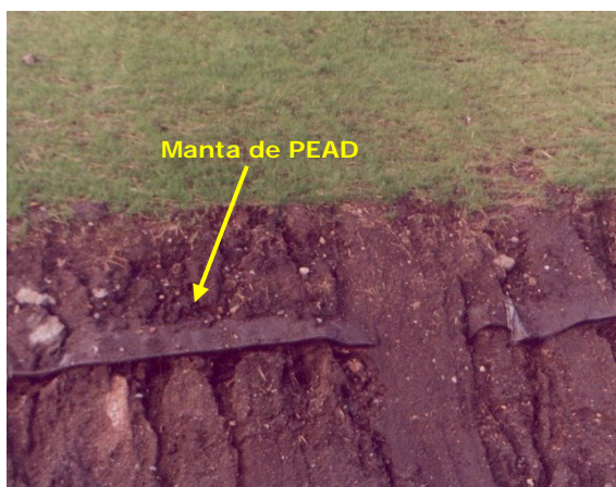
Figura 7.23.1-1: Detalhe da cobertura final prevista para o encerramento da CTR Santa Rosa.
