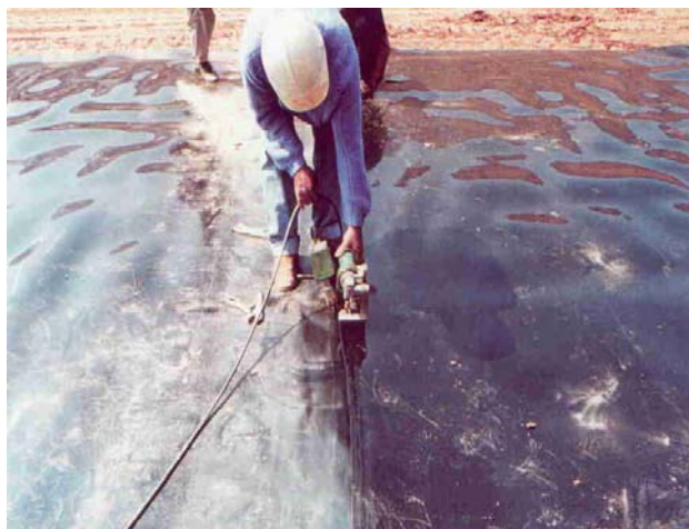
Figura 7.21.9-2: Detalhe da Soldagem Térmica da Geomembrana
